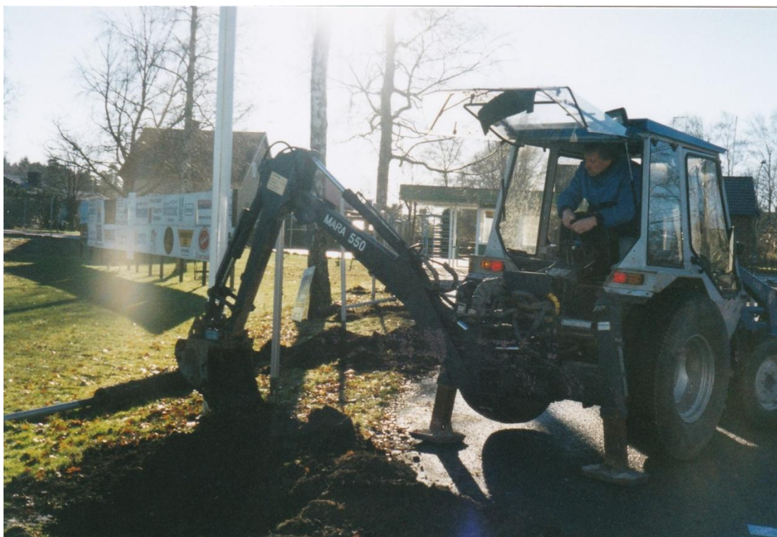
Jonny Linder gräver upp stolpar.
